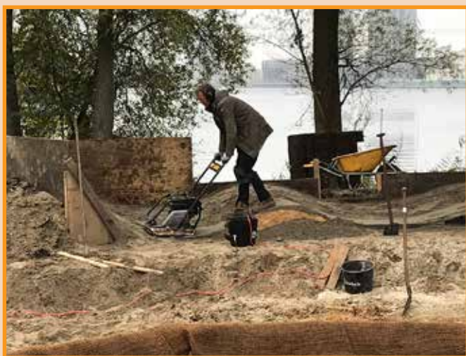
Het zandbed in model brengen (Foto: Emiel Versluis)
